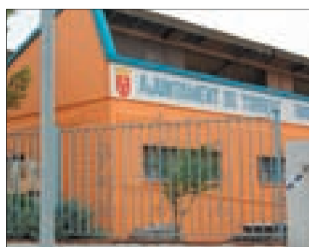
La Brigada de Obras se ubica actualmente en un solar en la zona de Parc Central.
