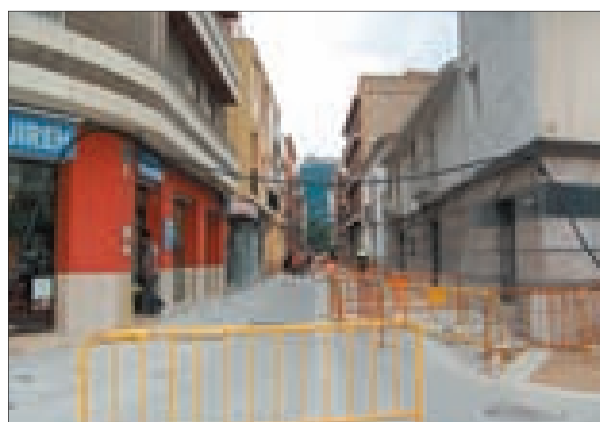
Obras de urbanización en la calle Sagra. 375.000 euros.
