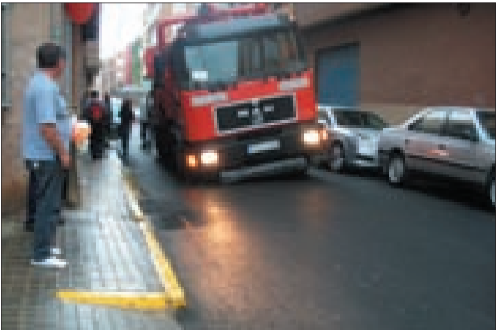
Un camión se quedó hundido en la calzada a los pocos días de instalarse los colectores de aguas en el barrio los Caracoles. Una chapuza.
