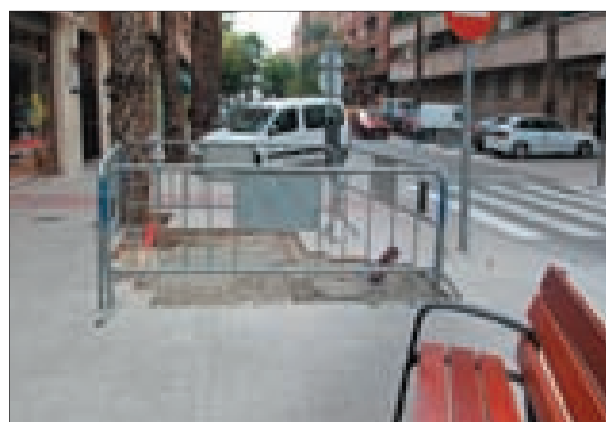
Obras de alumbrado en San Valeriano. 290.000 euros.
